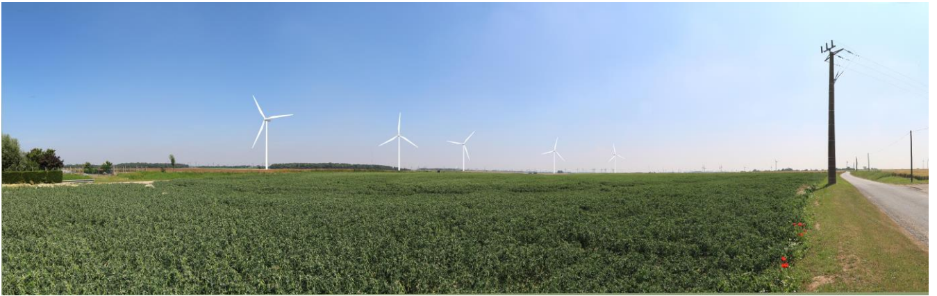
Figure 8 : Photomontage de l'implantation finale : éoliennes de 180 m bout de pale (110 m de hauteur de moyeu et 140 m de rotor) (source : JACQUEL ET CHATILLON)
